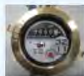
水道メーター写真
