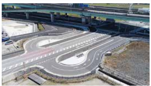
戸原の流通業務地区と国道201号線を接続する町道峰屋敷・向川原線を新設しました。
