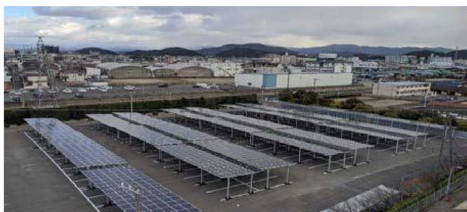
事業所駐車場へのソーラーカーポート導入事例 (花王和歌山工場) (出典:環境省ソーラーカーポート導入優良事例集(環境省))
