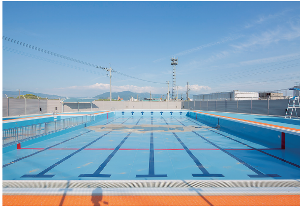
粕屋西小学校プール改修工事 1億8,468万円
