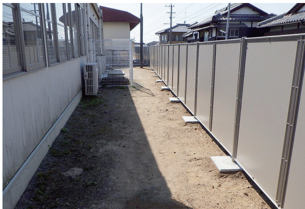
仲原小学校西側東側ブロック塀改修工事 475万円
