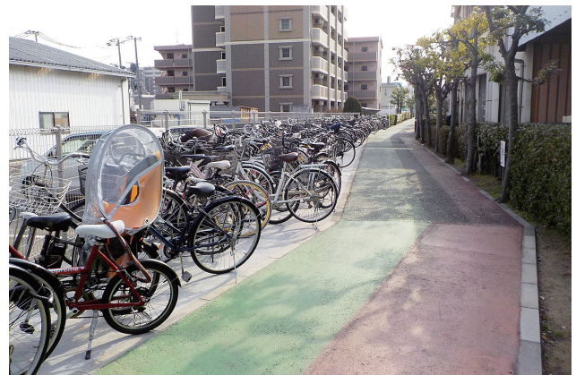
柚須駅駐輪場整備工事 596万円
