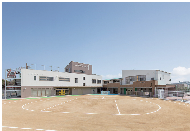
はこぶね認定こども園保育園部分増築工事 及び幼稚園部分建替工事 補助金 2億3,782万円
