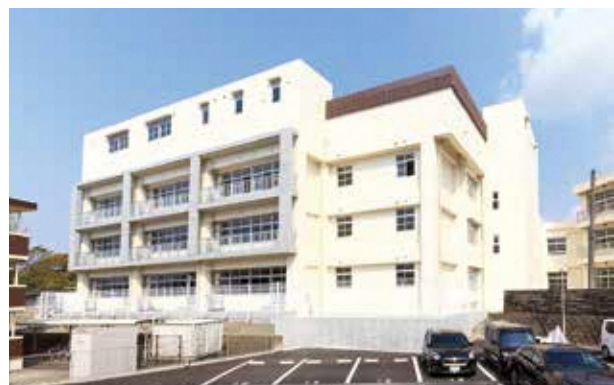
仲原小校舎増築・プール改修、西小・中央小トイレ改修 5億6,111万円
