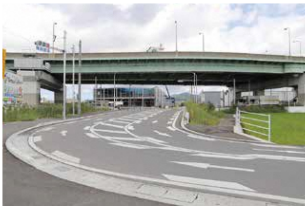
峰屋敷・向川原線の道路新設工事 1億2,371万円
