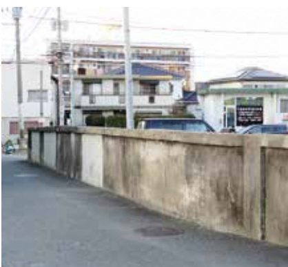
旧庁舎のブロック塀
