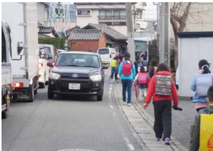
拡幅が急がれる県道(伊賀駅踏切付近)
