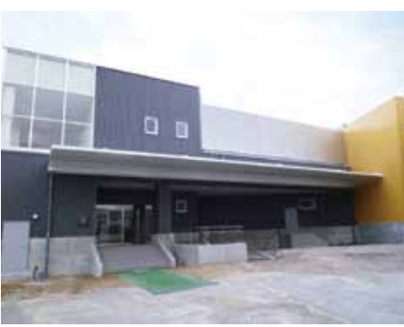
新給食センター建物
