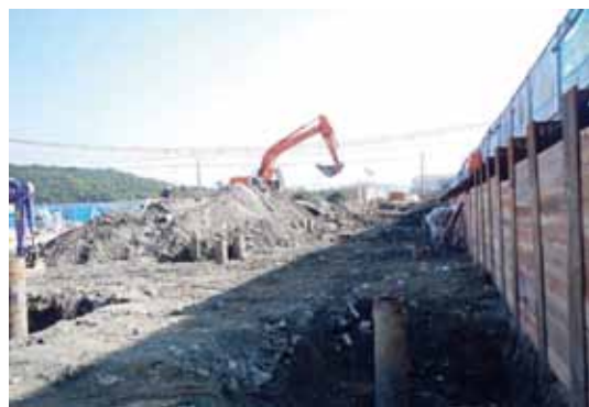
給食センター廃棄物撤去
