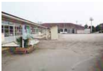
西幼稚園左棟の教室
