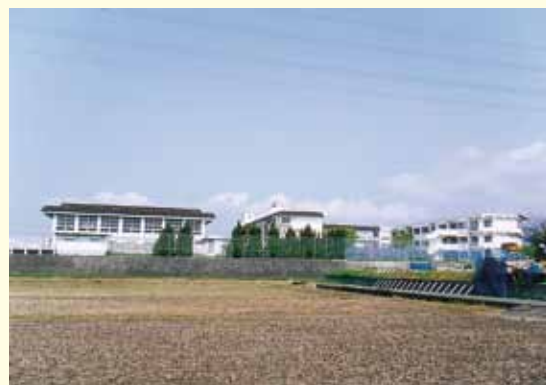
大規模改造工事予定の粕屋中学校
