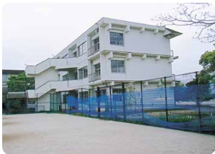
校舎増築が予定されている粕屋中学校
