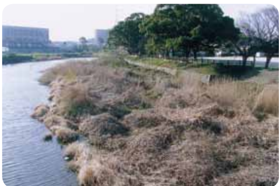
浚渫が急がれる多々良川
