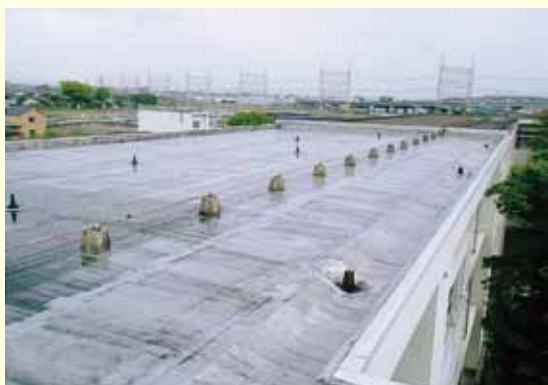
屋上防水工事予定の大川小学校
