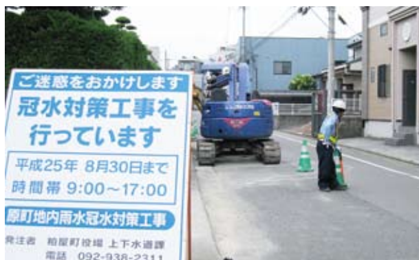
原町区のバイパス管渠工事の現場
