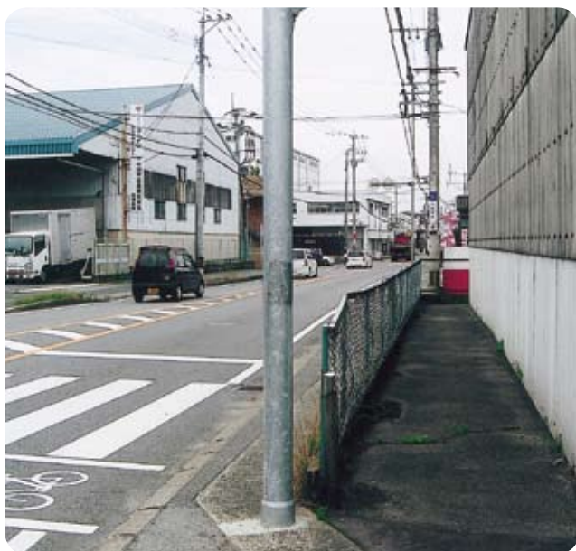
福岡インター入口交差点の歩道の現況
