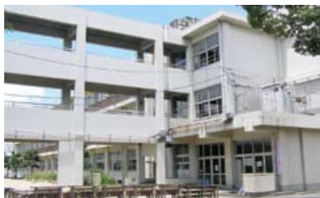
改修に入る大川小学校
