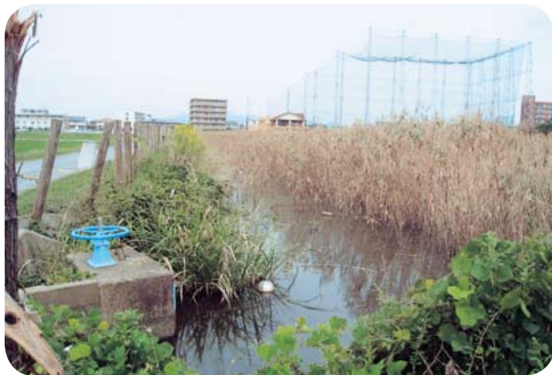
改修工事される阿恵大池
