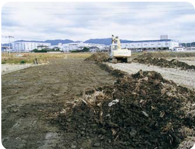
水害後の農地土砂除去工事(12月) 1.43ヘクタール
