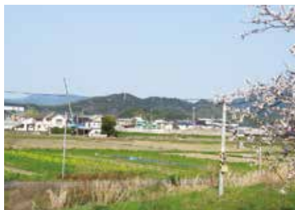
酒殿駅から望む建設中の(仮)かよいちよう保育園
