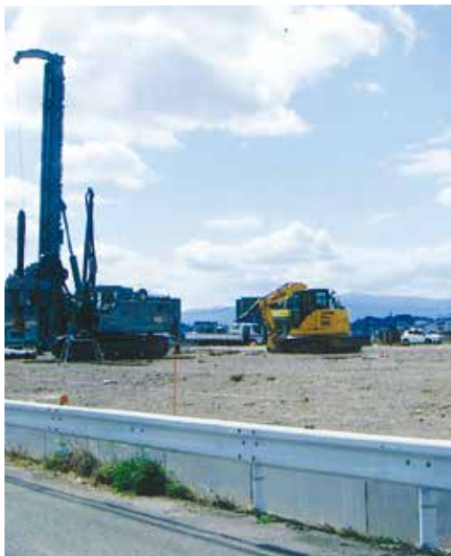
新しく開園保育園の工事現場
