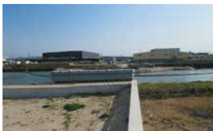
多々良川に新設の橋(工事中)
